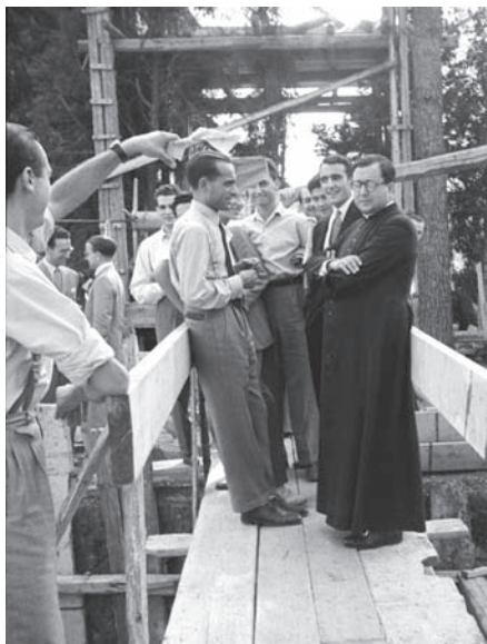
Verano de 1949: Villa Tevere en obras. Frente a san Josemaría, Armando Serrano. Entre ambos, el último al fondo es Fernando Delapiente.
